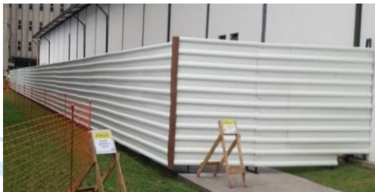
FIGURA 05: Ref. TAPUME COM TELHA METÁLICA
