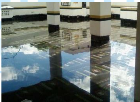
FIGURA 29: REF. TESTE DE ESTANQUEIDADE
